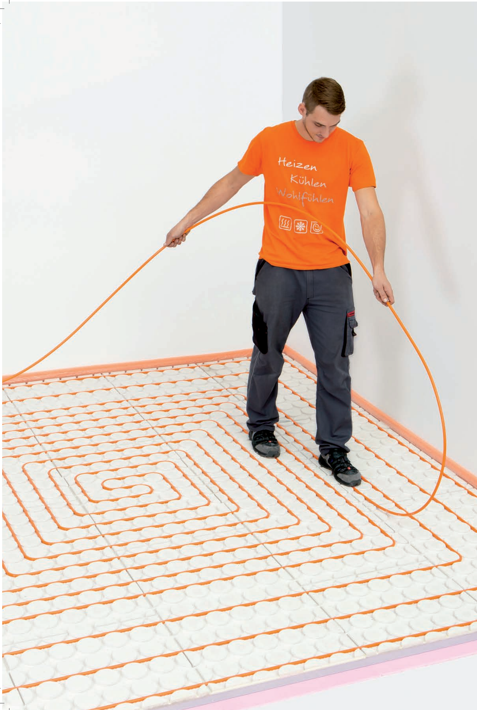
Podlahové vytápění pro suchou výstavbu 20 mm
